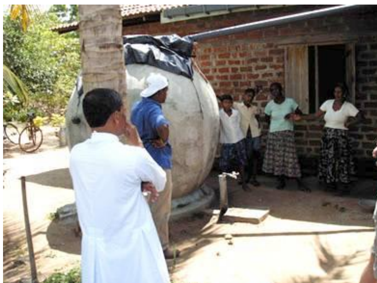
Father Edward, Chaminda en de familie die tijdens het droogte seizoen via hun dak het regenwater opvangen en dit opslaan in de betonnen tank van 5000 liter.
